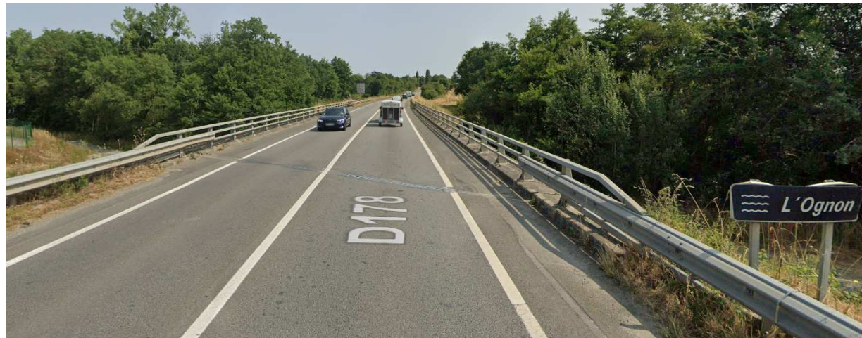
Figure 57 – Franchissement de l'Ognon- ouvrage à doubler
