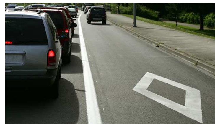
Figure 54 – Signalisation au sol de la VR2+
