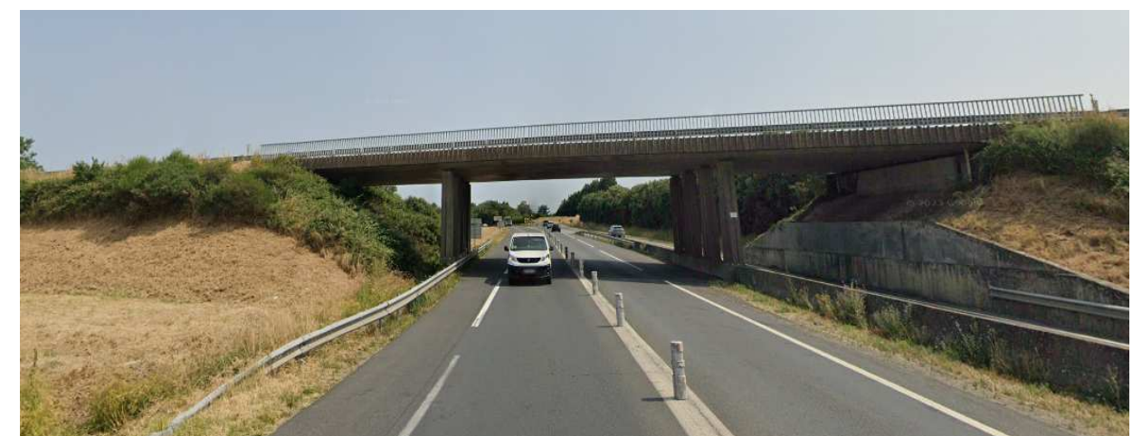
Figure 62 – Passage supérieur au franchissement de la RD137 - Ouvrage conservé en l'état
