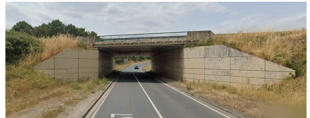
Figure 60 – Passage inférieur sur la RD57 au niveau de l'échangeur du « Taillis » - Ouvrage conservé en l'état
