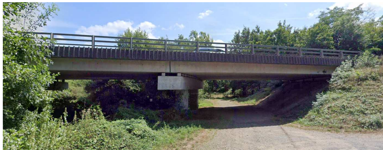
Figure 59 – Franchissement de l'Ognon (vue depuis le chemin agricole) - ouvrage à doubler
