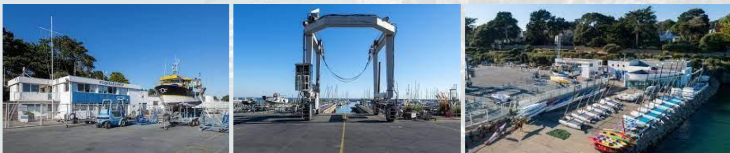
Les installations et les équipements actuels sont à retravailler
