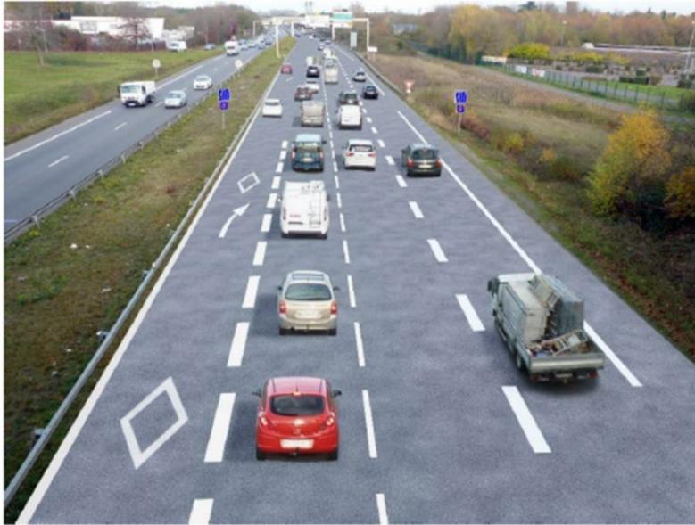
Photomontage d'une voie réservée sur la RD 723 à Bouguenais © Département de Loire-Atlantique
