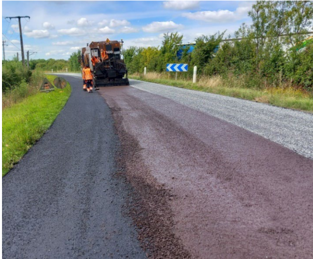
Travaux de renouvellement de la RD 164 été 2023 Chantier de Matériaux Bitumineux Coulés à Froid © Département de Loire Atlantique
