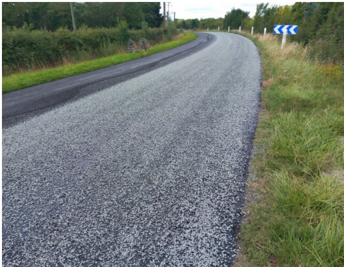
Travaux de renouvellement de la RD 164 été 2023, chantier de Matériaux Bitumineux Coulés à Froid (MBCF) © Département de Loire Atlantique
