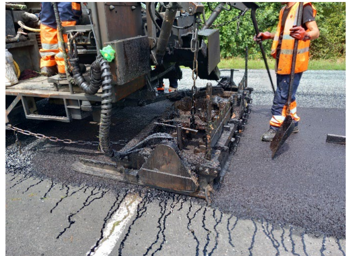
Travaux de renouvellement de la RD 164 été 2023 Chantier de Matériaux Bitumineux Coulés à Froid © Département de Loire Atlantique
