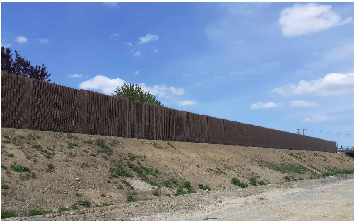
Écran en béton avec grille anti-tag le long de la RD 751 à Saint-Léger-Les-Vignes © Département de Loire-Atlantique
