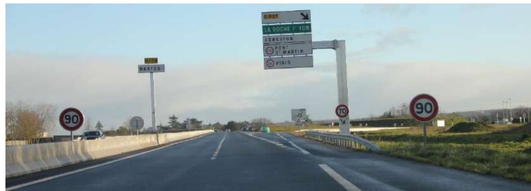
L'échangeur de Viais est surélevé par rapport au terrain naturel, offrant une vue dégagée pour les usagers sur la campagne environnante. (Vue n°18)
