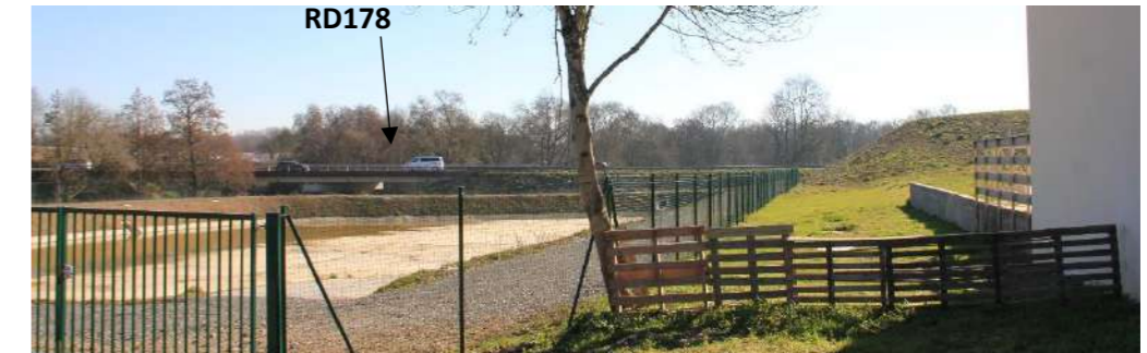
Covisibilité entre les habitations situées à la sortie de Viais et la RD 178 (vue 35)
