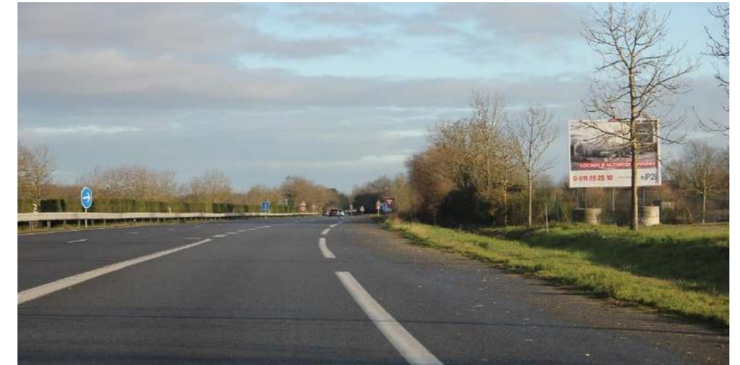
Vue en direction de Viais depuis la voie d'insertion de l'échangeur de Tournebride (vue n°1)
