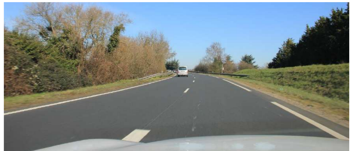
La végétation et la présence du merlon canalisent la vue sur la bretelle d'insertion vers l'A83 (vue 30)
